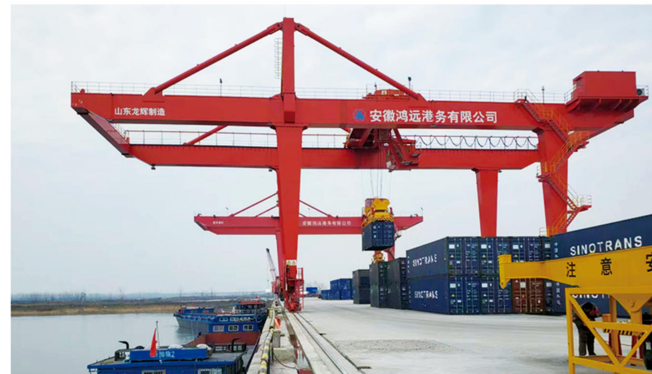
安徽鸿远港务有限公司岸边集装箱门机项目
