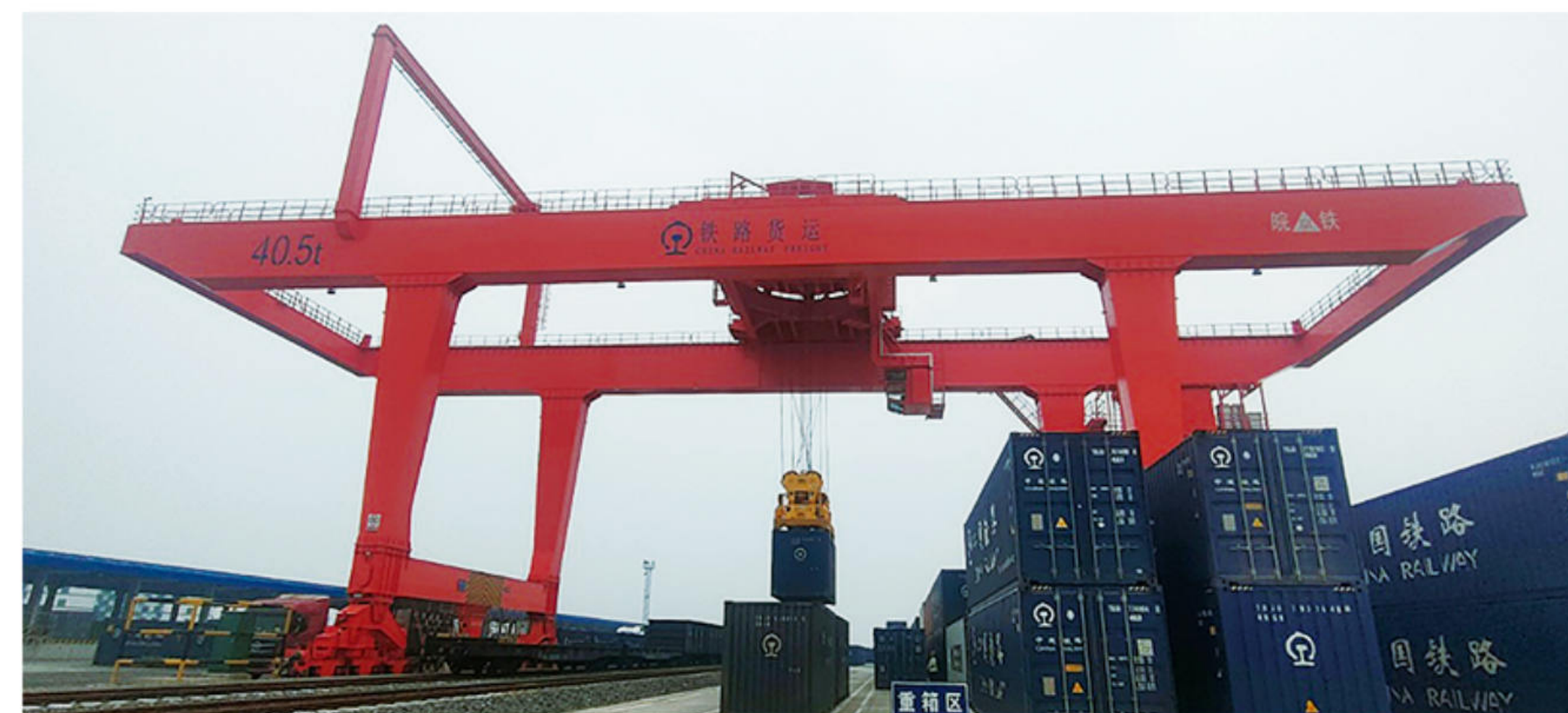
上海铁路蚌埠皖铁起重机械有限公司项目
