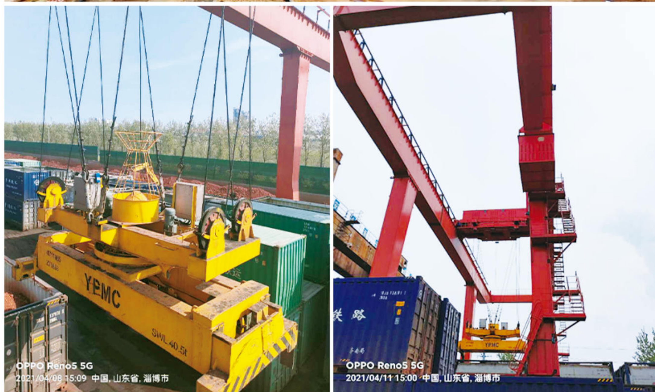
淄博金泰铁路储运有限公司项目
