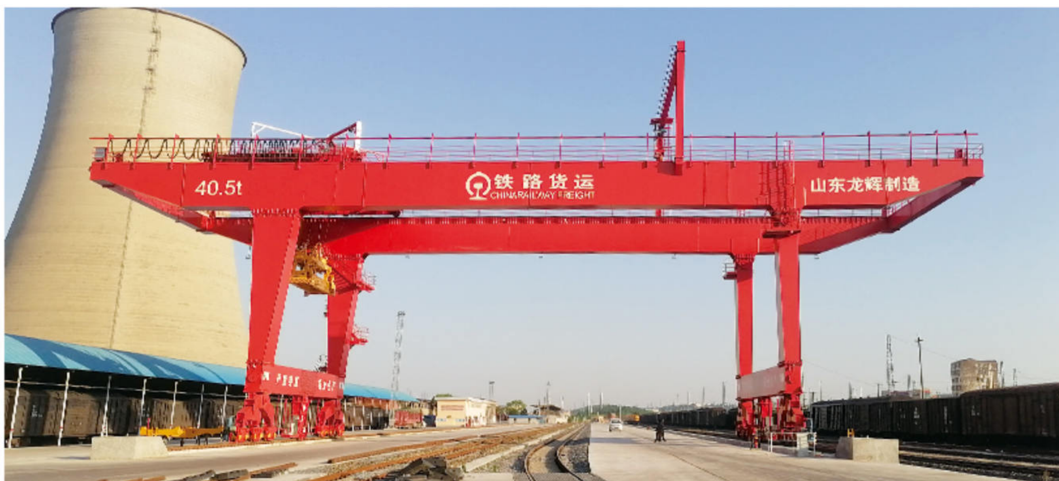
中国铁路武汉局集团有限公司荆州货场项目
