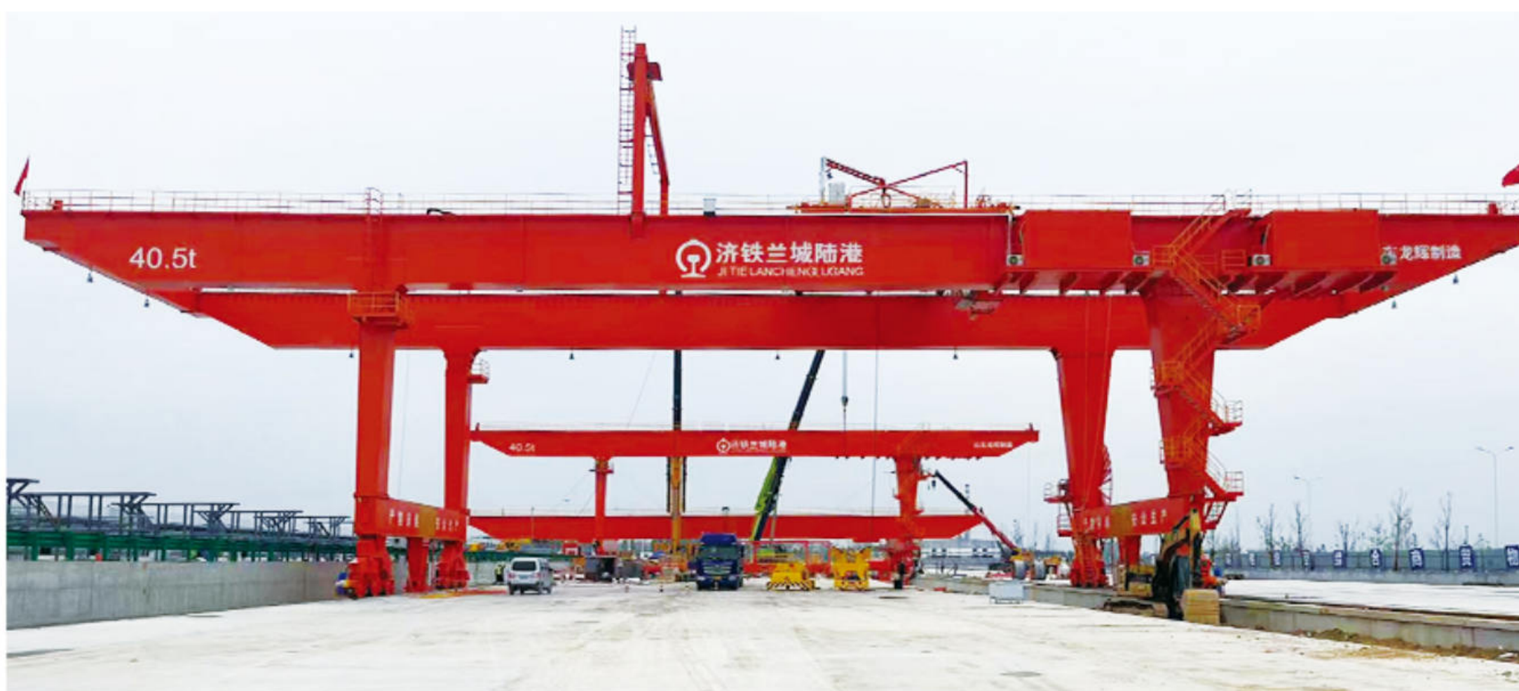
中国铁路济南铁路局济铁兰城陆港项目
