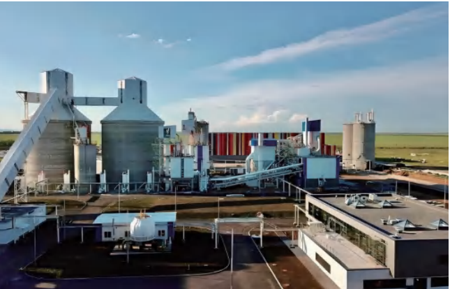
俄罗斯水泥生产线项目 Russia Cement Production Line Project
