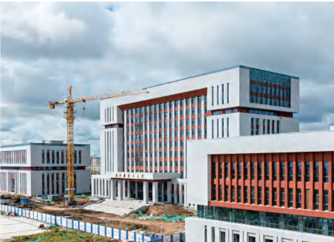
哈尔滨医科大学新建校区工程项目 Harbin Medical University New Campus Construction Project
